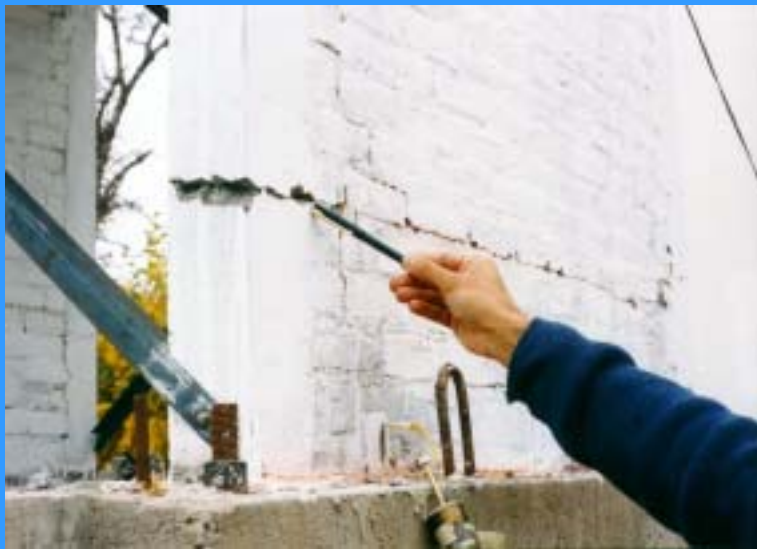
Falla por flexión en muros
